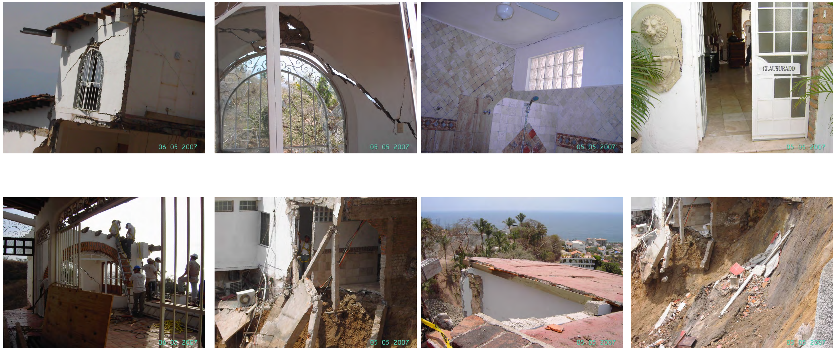
Figura 40. Fotos de los daños causados por el deslizamiento de ladera que afecto en la primera semana de mayo del 2007 la zona del fraccionamiento El Campanario en Conchas Chinas, donde las edificaciones afectadas tuvieron que ser demolidas en su totalidad.
