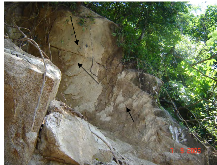
Figura 45. Las flechas indican las zonas de desprendimiento en la cima del cerro, las fracturas existentes presentaron un buzamiento (inclinación) hacia el sur de 24°, que es una pendiente inestable y muy susceptible a deslizarse nuevamente con un evento disparador, como lo es una lluvia, un sismo pequeño, una explosión o simplemente la gravedad.
