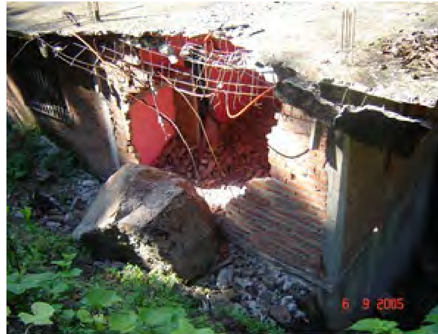
Figura 48. Efectos sobre las edificaciones de los bloques de roca caídos y rodados, los cuales dañan gravemente las estructuras de las casas, tal y como se muestra en estas seis imágenes.
