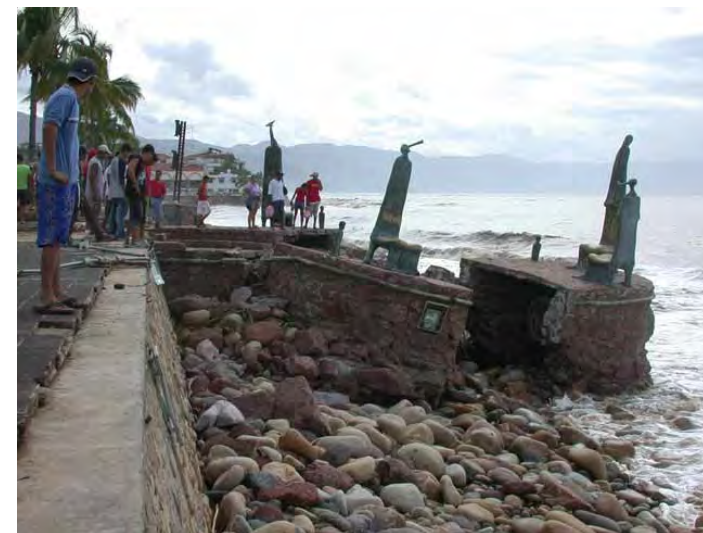
Figura 68. Imágenes que muestran los efectos del huracán Kenna el 25 de octubre del 2002, que daño gravemente la zona costera donde se ubica el área hotelera y comercial en el puerto.
