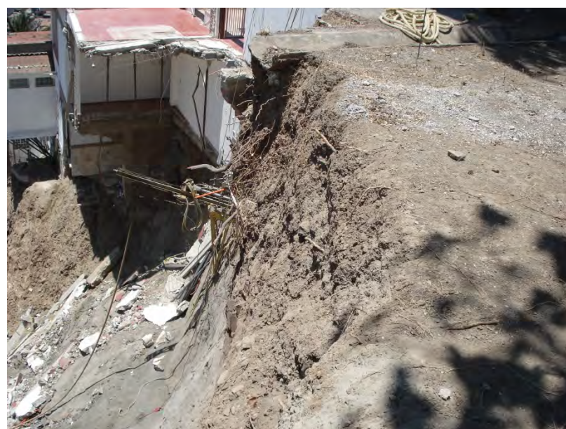
Figura 39. Fotos del deslizamiento de ladera que afectó en la primera semana de mayo del 2007 la zona del fraccionamiento El Campanario en Conchas Chinas, el cual afectó varias edificaciones en el sitio.
