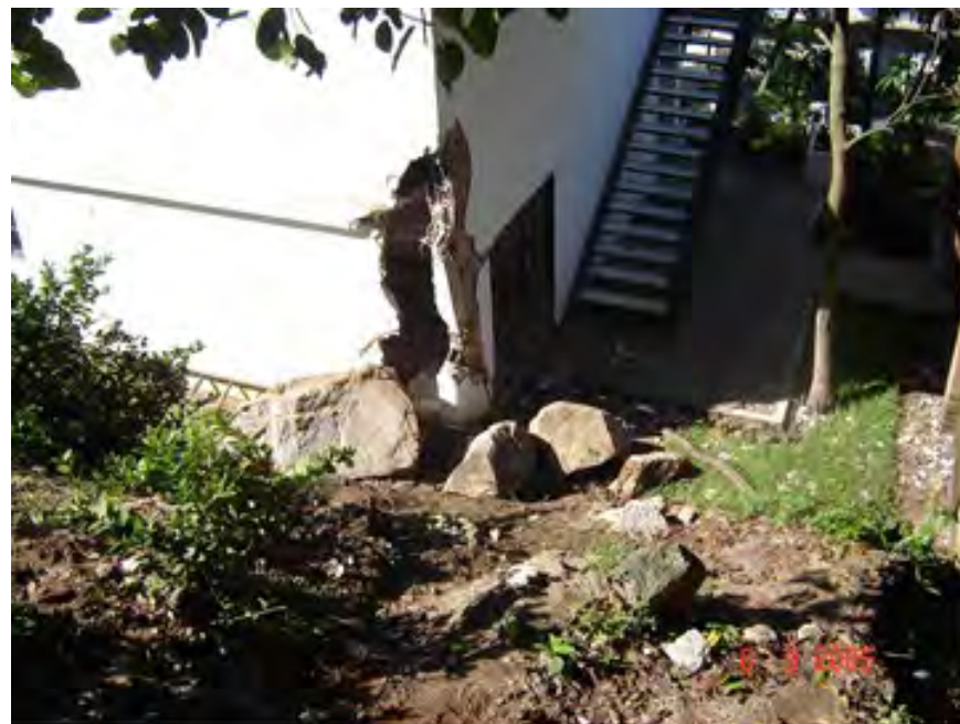
Figura 48. Efectos sobre las edificaciones de los bloques de roca caídos y rodados, los cuales dañan gravemente las estructuras de las casas, tal y como se muestra en estas seis imágenes.
