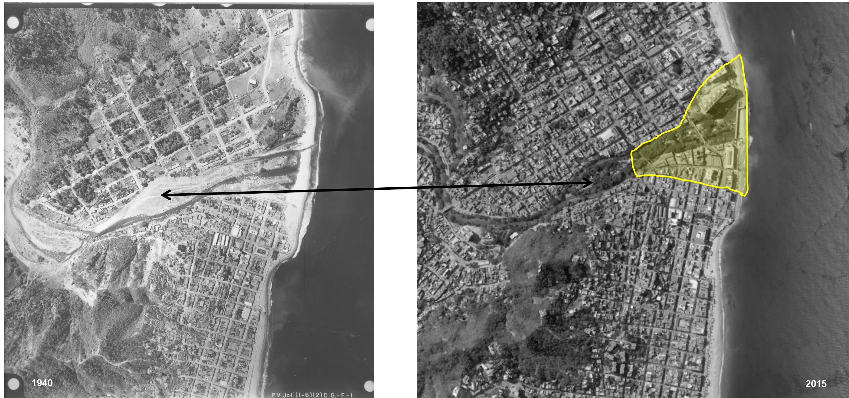
Figura 78. Desembocadura del río El Cuale, donde se observa como el cauce del río ha sido reducido en su talweg y urbanizado en su trayecto y en su delta de desembocadura (polígono amarillo), el cual fue ocupado por construcciones, lo que ha reducido la superficie de la playa por reducción del flujo de arena proveniente de este río. Otro punto es que la isla no existía en 1940 (flecha negra), En las elevaciones próximas también han sido urbanizadas.
